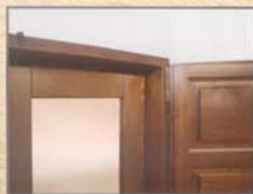
TERMINACIÓN CON CONTRAVENTANA Y MONTADA SOBRE UN SEGUNDO MARCO INTERIOR
